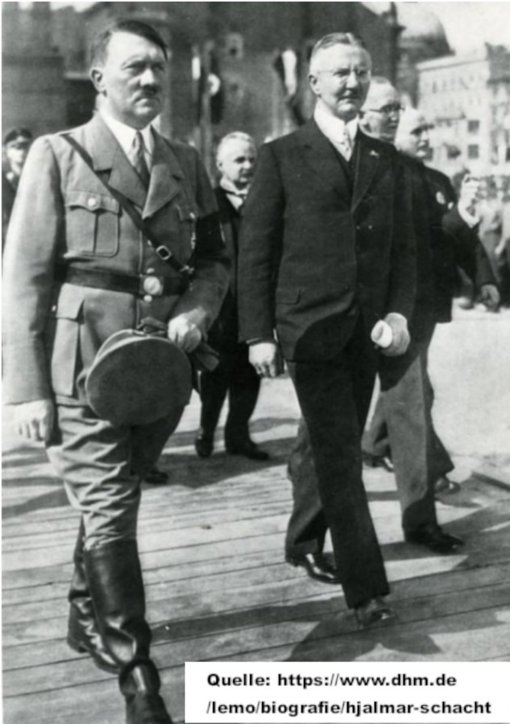
Adolf Hitler und Hjalmar Schacht bei der Grundsteinlegung des neuen Reichsbankgebäudes, 5. Mai 1934
