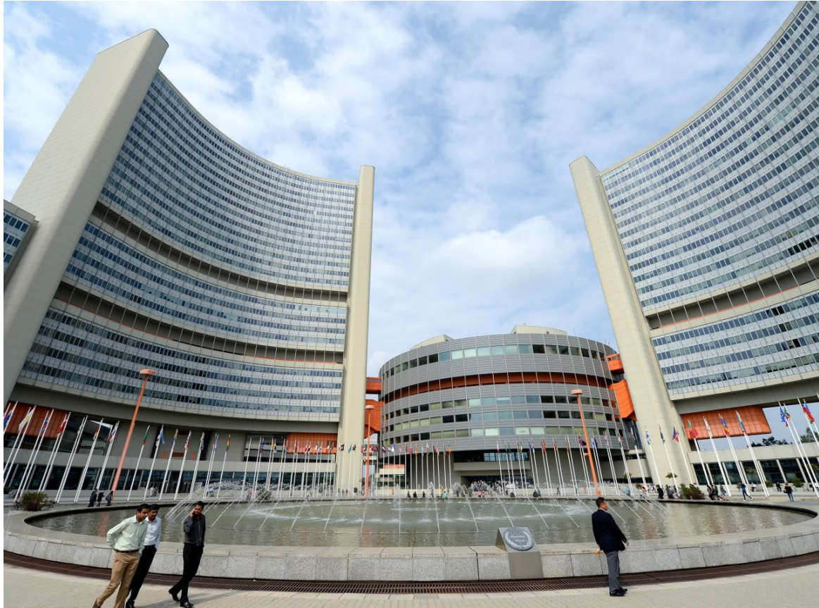
okkultes UNS-Gebäude in Wien
