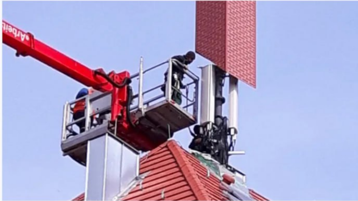
Ein Sendemast: Arbeiter verkleiden auf einem Wohn- und Geschäftshaus eine Mobilfunksendeanlage mit einer Schornsteinatruppe. (Quelle: Kilian Moritz/dpa-bilder)
