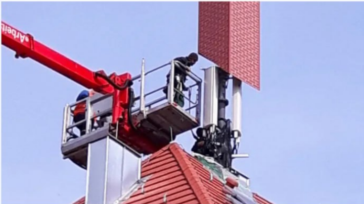
Ein Sendemast: Arbeiter verkleiden auf einem Wohn- und Geschäftshaus eine Mobilfunksendeanlage mit einer Schornsteinattrappe. (Quelle: Kilian Moritz/dpa-bilder)
